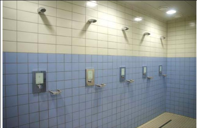
10: Die Schell Wandeinbau-Dusche Linus im Seebad in Schorndorf verfügt über eine Radar-Sensorik: Diese registriert die Anwesenheit des Gastes und stoppt den Wasserfluss automatisch, sobald der Sensorbereich verlassen wird. 5 Sekunden beträgt die Nachlaufzeit, damit Seifenreste restlos weggespült werden.
